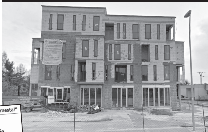
↓ novácka stavba storočia
