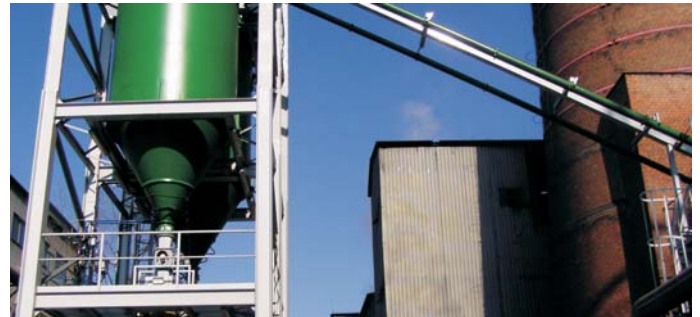
▲ Rekonštrukcia odprášená výroby acetylénu - časť odprášená doprava uhľíkatých surovín. Foto: fš
